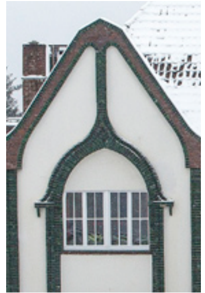
53.1 Peter Behrens, Haus Behrens, 1901 Ansicht von Norden, Foto 2013
