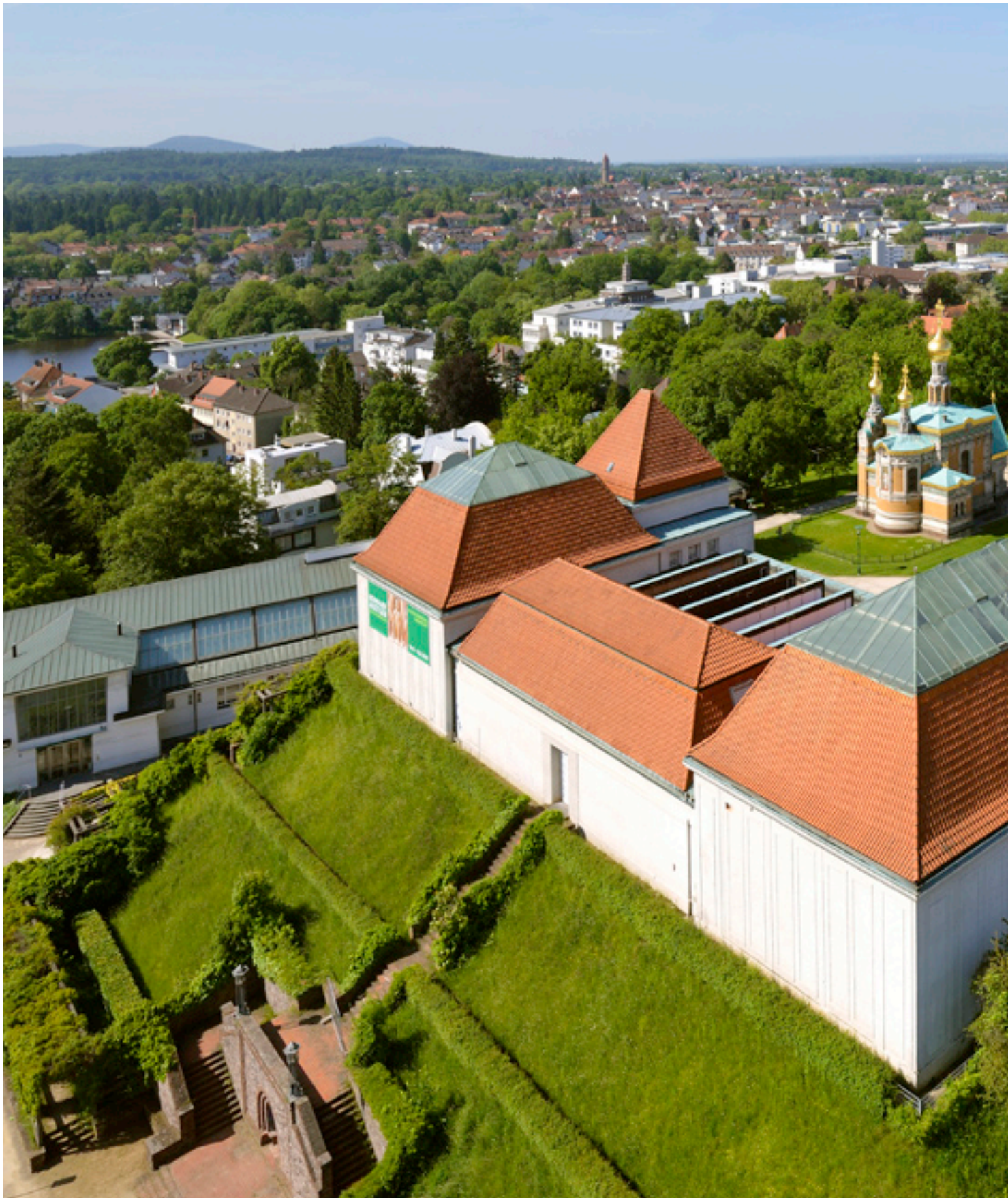
58.1 Joseph Maria Olbrich, Ausstellungsgebäude und Hochzeitsturm, 1908, Blick von Nordosten, Foto 2013
